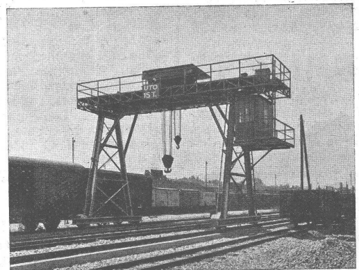
Fahrbarer Bockkran mit zwei Hubwerken
