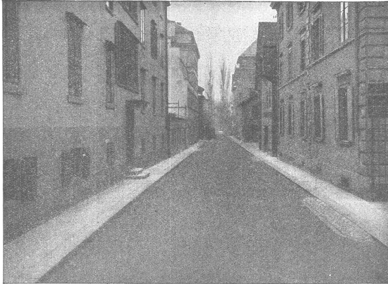
GLARNISCHSTRASSE ZÜRICH Walz-Asphalt: Topeka, 6 cm stark
