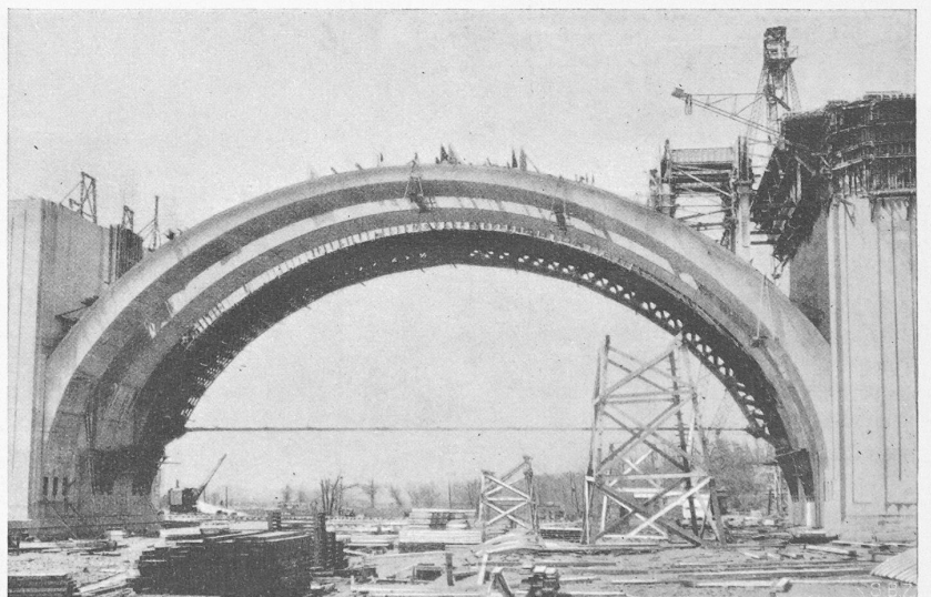
Abb. 61. Raritanbrücke bei New Brunswick N. J. Dreiteilige Gewölbe von 61,5 m Spannweite (vergl. auch Abb. 60 auf Seite 303).
