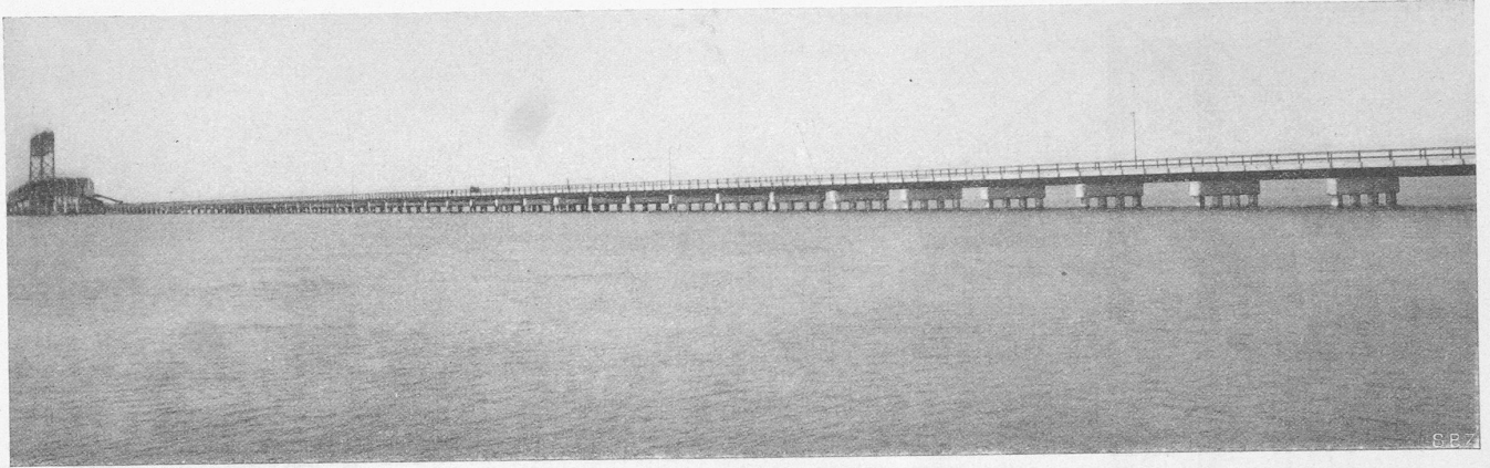
Abb. 48. Brücke über den James River bei Newport News, dritter Brückenabschnitt von 7,2 km Länge. Pfahlängen bis 35 m im Gewicht von 31 t. Die bewegliche Brücke links im Bild hat eine Weite von 90 m.
