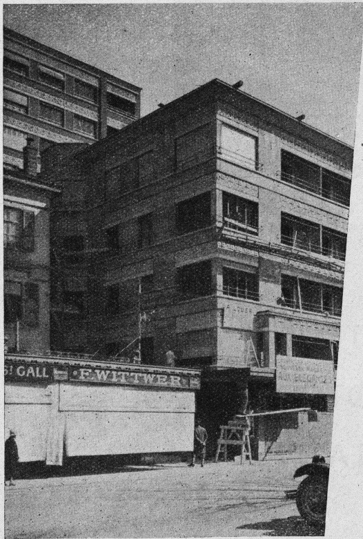
Geschäfts- u. Wohnhaus in Montreux. • Architekt: A. Schorp, Montreux. • Unternehmer: Boulenaz, Dorner & Payot, Montreux.
