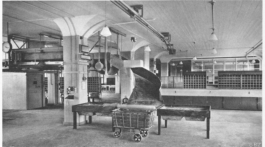
Abb. 30. Briefausgabe im 2. Stock: Ausmündung des Sack-Elevators auf den Auspacktisch.
