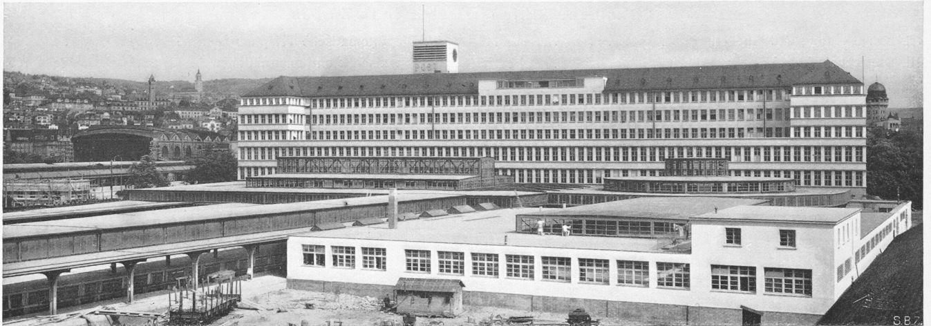
Abb. 4. Gesamtbild aus Westen: links Post-Bahnsteige, rechts vorn Garagen und Werkstätten, dahinter das Hauptgebäude.
