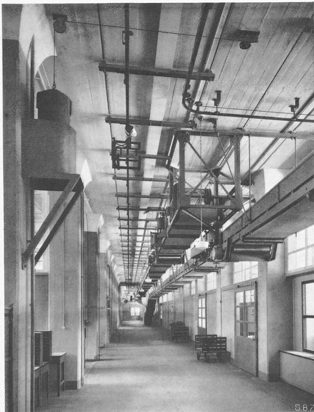
Abb. 28. Hängebahn und Förderbänder im Gang des Erdgeschosses
