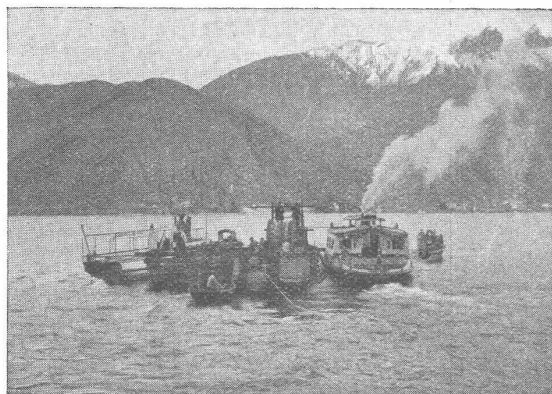
Abfahrt der Verlegeflotte in Poiana
