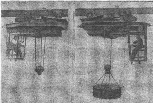
Elektrisch betriebene Führer-Laufwinden von 5 Ts Tragkraft, geliefert an Schweiz. Grössgiessereien.
