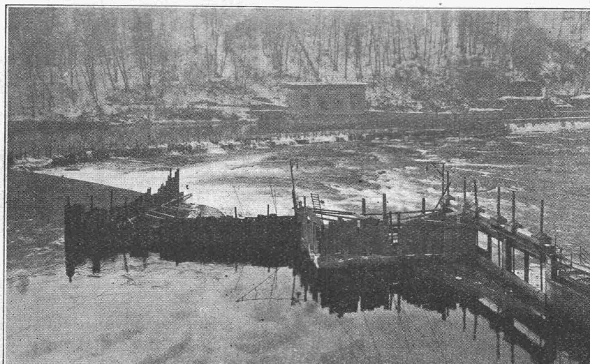
Konsolidierungsarbeiten am Moser- damm Schaffhausen
