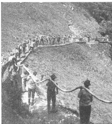
Fernkabelverlegung am Walensee
