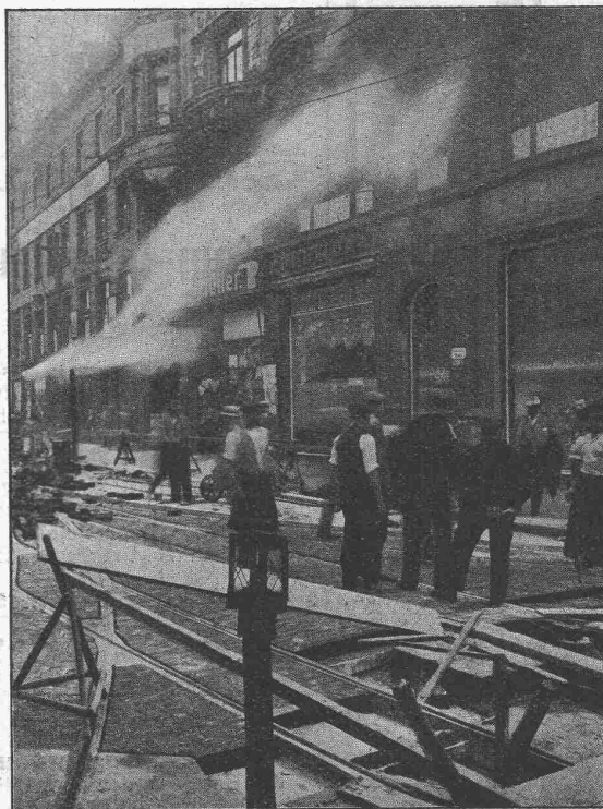
Strassenbahn Chemnitz. Verlegen der Geleise innerhalb 24 Stunden ermöglicht durch Zusatz von SIK A-3 zum Beton für den Geleiseunterbau.
