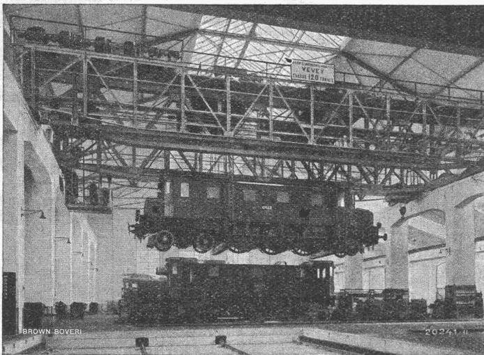
Belastungsprobe eines Lokomotivehebkranes der Reparaturwerkstätte Yverdon
