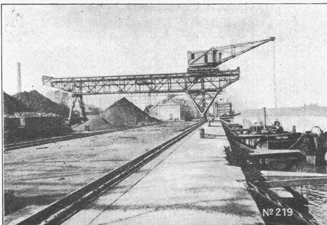
Verladeanlage im Hafen von Bilbao.
