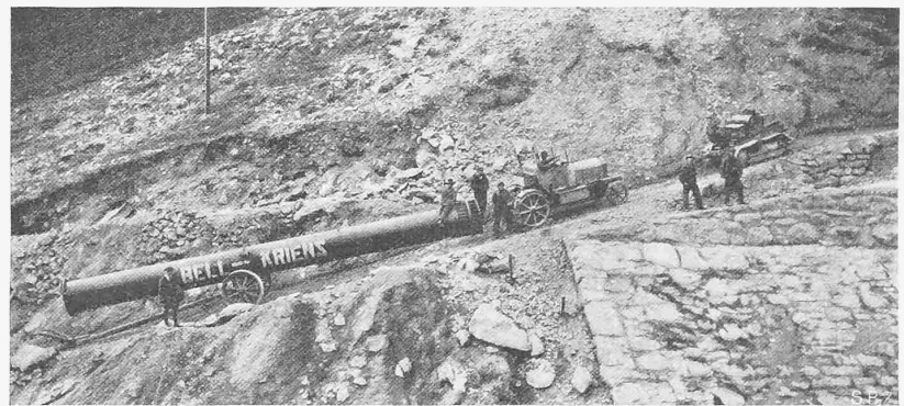
Abb. 78. Rohrtransport auf einer Steigung von 30%.
