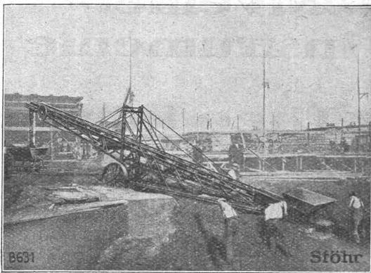
zum Ausschachten von Baugruben, zum Be- und Entladen von Wagen aller Art usw.
