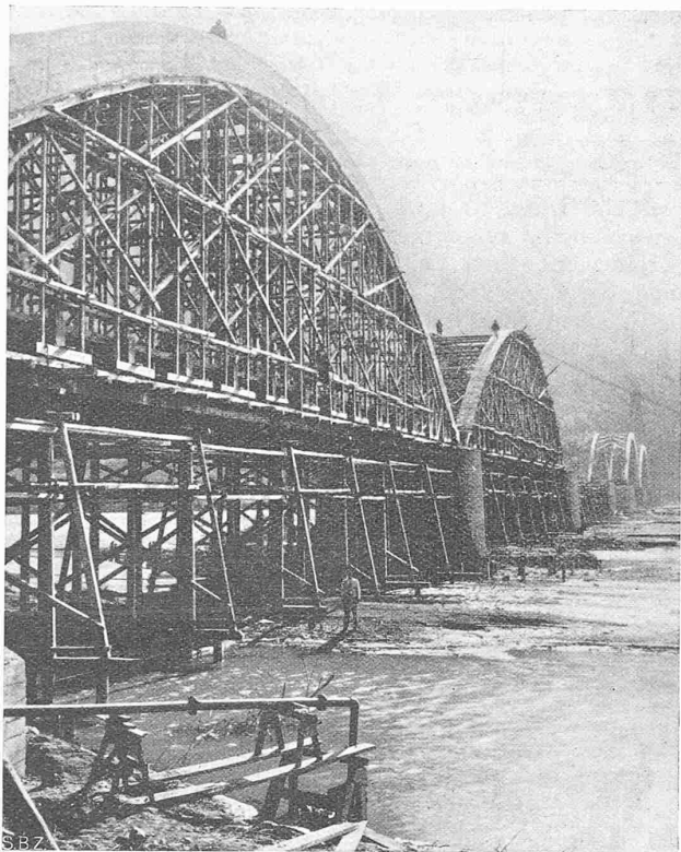
Abb. 7. Lehrgerüste zweier Hauptöffnungen.
