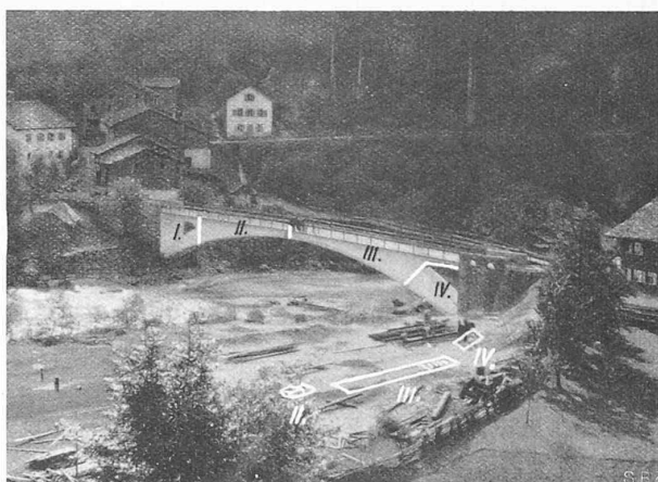
Abb. 8. Lage der Brückentrümmer oberhalb der linken Uferböschung.
