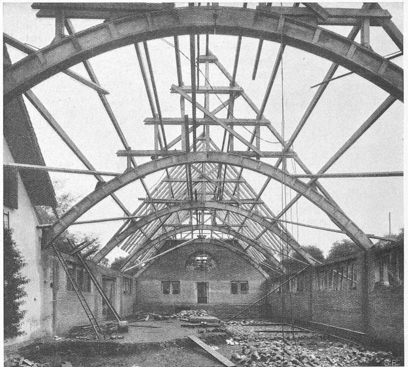
Abb. 3. Dachkonstruktion in Holz nach Bauweise Tuchscherer, von Ing. W. Stäubli, Zürich.
