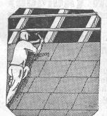
Diana-Unterdachplatten: Zweckmässigstes Dachunterkonstruktionsmaterial für Neu- und Umbauten. / Bei bestehenden Bauten können die Dianaplatten ohne Dach-umdeckung leicht und rasch vom Dachinnern aus angebracht werden.
