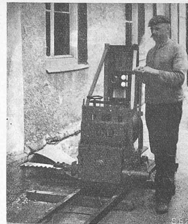
Mauersäge zur Vornahme von Isolierungen gegen Feuchtigkeit in bestehenden Sockelmauern.
