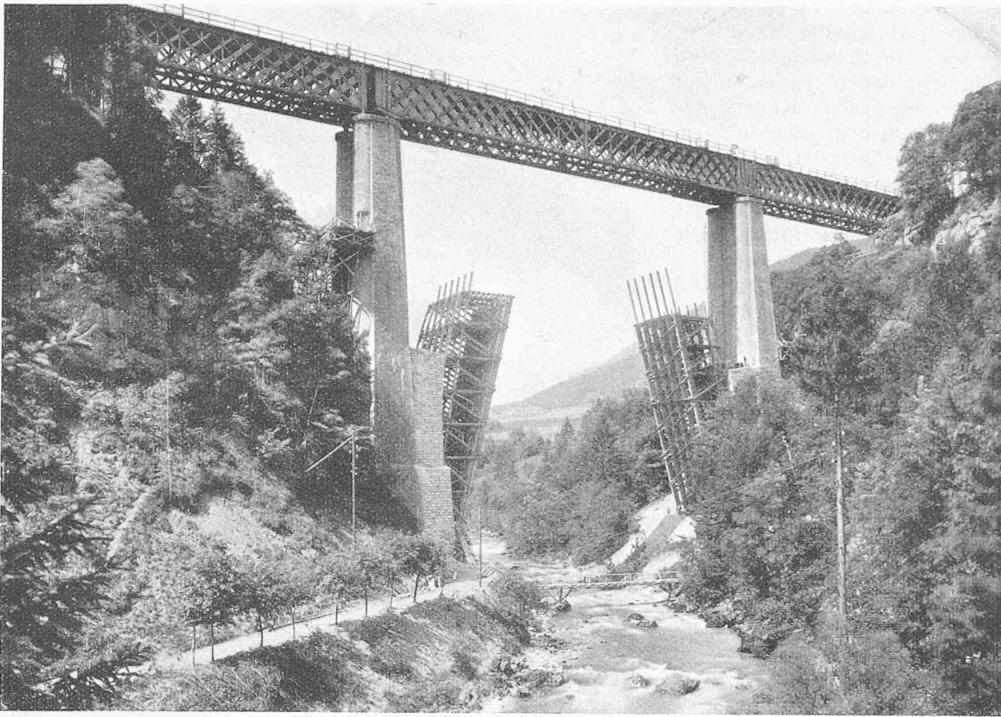
Abb. 5. Erstellung des Lehrgerüsts für den mittlern Bogen. Ansicht flussaufwärts.
