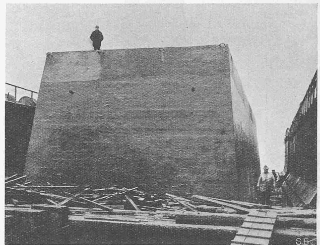
Abb. 9. Eisenbeton-Senkkasten für die Oderbrücke Stettin.
