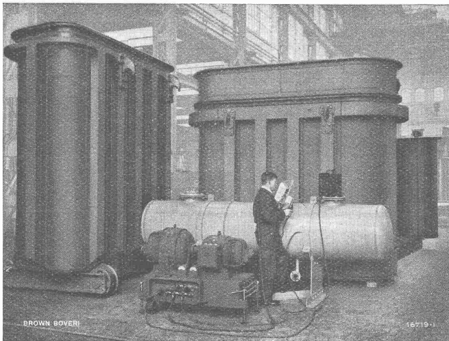
Mit Brown Boveri Lichtbogen-Schweißgruppen elektrisch geschweißte Groß-Transformatorkessel.
