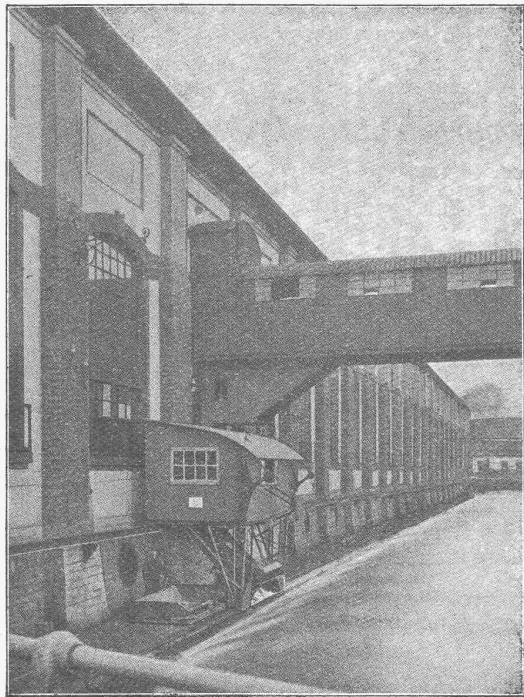
KRAFTÜBERTRAGUNGSWERKE RHEINFELDEN A.-G. (BADEN) Kombinierte Rechen-Reinigungsmaschine mit doppeltem Schwenkkran
