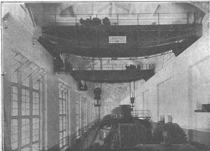
Zwei elektrische Laufkrane von je 50 Tonnen Tragkraft in der Zentrale Mühleberg der Bernischen Kraftwerke A.-G.
