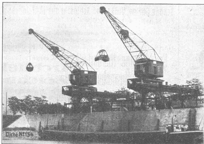
Hafenkrane für Greifer- und Stückgutbetrieb. Rheinhafen Kleinhüningen Basel.
