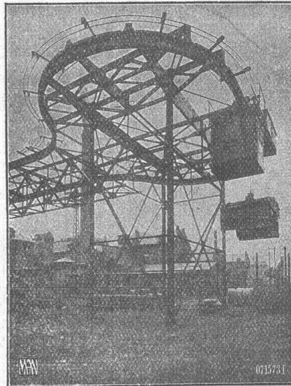
Kohlenförderanlage Kraftwerk Bingen
