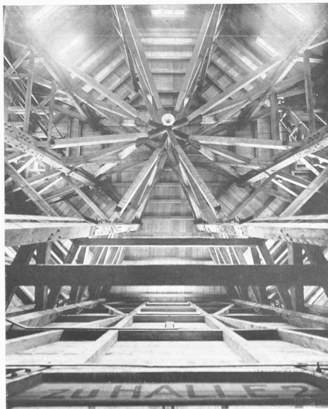
Abb. 10. VERTIKALBLICK IN DIE TURMKONSTRUKTION
