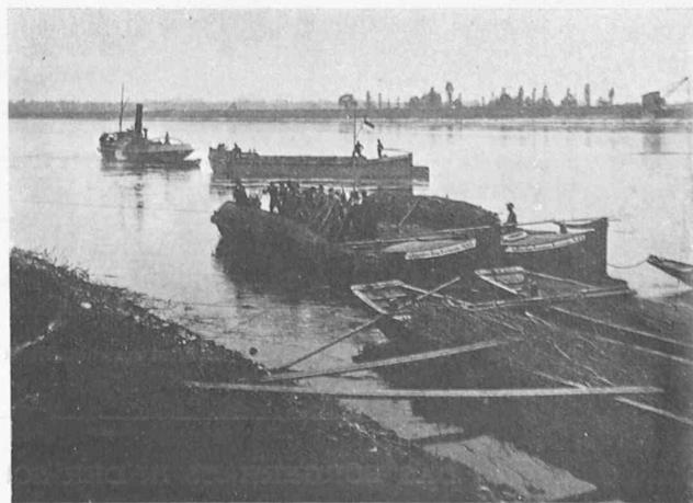
Abb. 4. Abrollen einer fertigen Senkwurst.
