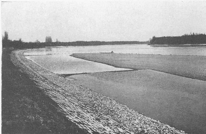
Abb. 6. Unterbindung einer Nebenrinne durch Bühnen-Einbau.
