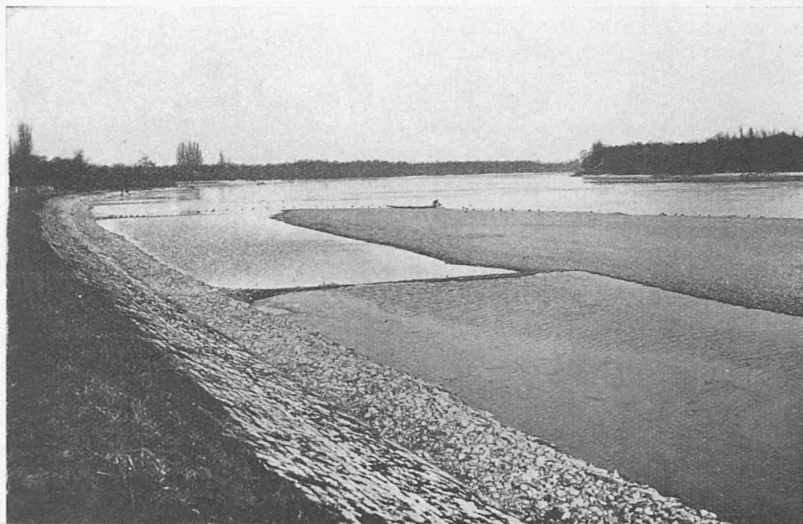
Abb. 6. Unterbindung einer Nebenrinne durch Bühnen-Einbau.
