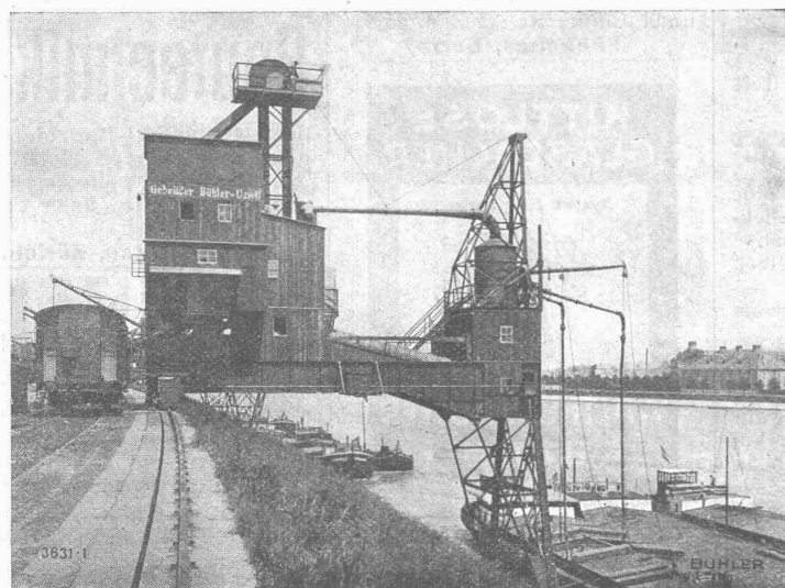
Pneumatischer Getreideheber, ausgeführt von Gebrüder Bühler, für eine Stundenleistung von 70 bis 80,000 kg Weizen, geliefert für das Schiffsahrtsamt des Kantons Basel-Stadt für den Rheinhafen Basel-St. Johann
