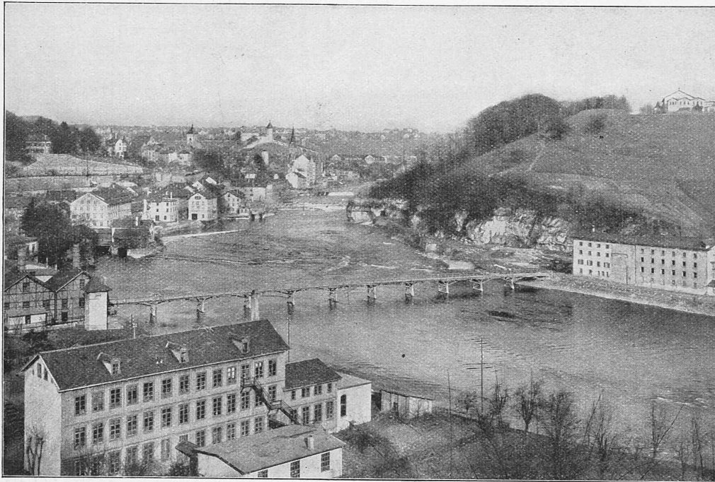
Abb. 4. Gesamtansicht flussaufwärts der „Lächen“ bei Schaffhausen vom Flurlingersteg bis zum Moserdamm, von der Terrasse des Charlottenfels aus im März 1924. — Die grosse Platte über der linksufrigen Hälfte des Flurlingersteges ist erkennbar; nahe dem vordern Rande dieser Platte Baustelle für das Kraftwerk. Mitte des Bildes Baustelle für das automatische Wehr, dahinter Felsporn bei Zentrale B. Ganz rechts Baustelle für die Grossschiffahrtsschleuse.
