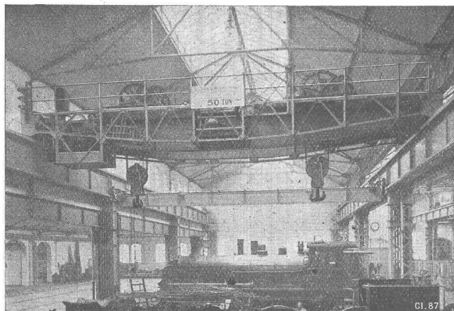
Lokomotivhebekran von 50 Tonnen Tragkraft, in den Reparaturwerkstätten der S. B. B. in Zürich.
