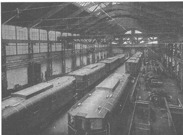
Lokomotiv-Montagehalle mit elektrischen Lokomotiven für Südafrika
