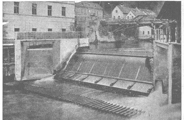
Dachwehr in der Mürz der Kabelwerke Felten & Guillaume, Bruck a. d. Mur.
