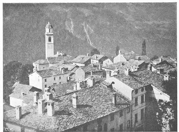
Blick über die Dächer von Soglio, von der Bergseite her
