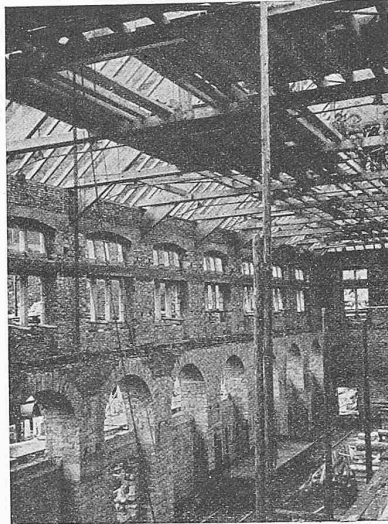
Abb. 43. Innenansicht des Maschinensaaes während des Baues.
