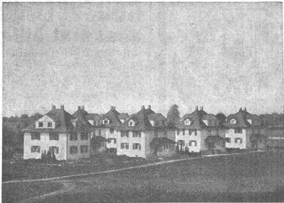
Wohnhäuser in Ziegelbrücke Bedachungen: Eternit-Doppeldach, kupferbraun
