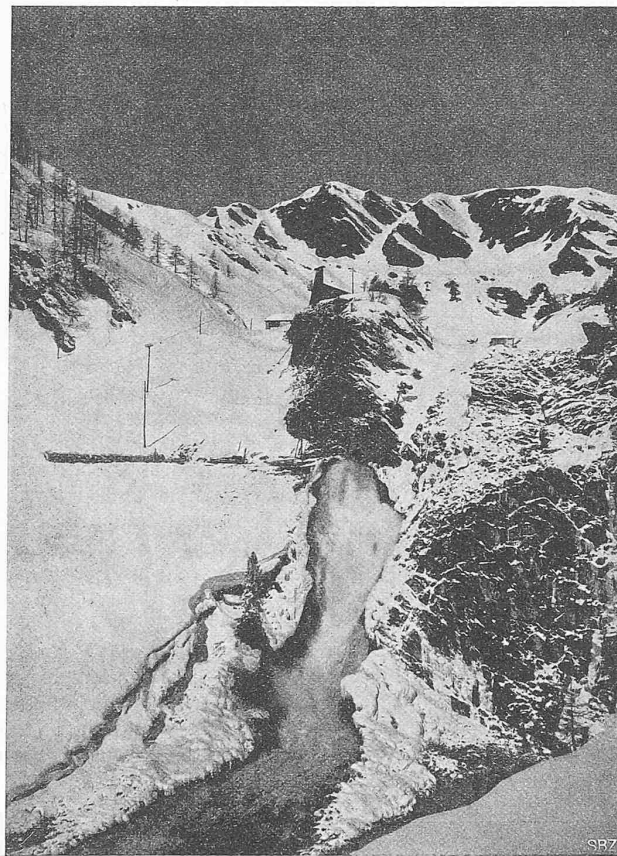
Abb. 7. Ausmündung des Grundablast-Stollens in den Fossbach (6. III. 1917).
