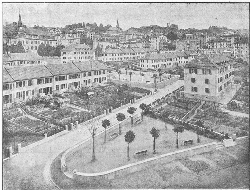
Abb. 3. Genossenschafts-Wohnbauten in Prélaz bei Lausanne (aus Süd-West).
