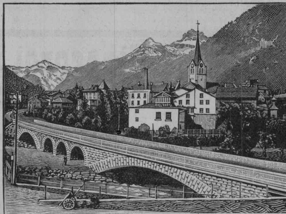
Eisenbahnbrücke ü. d. beiden Lintharme i. Schwanden
