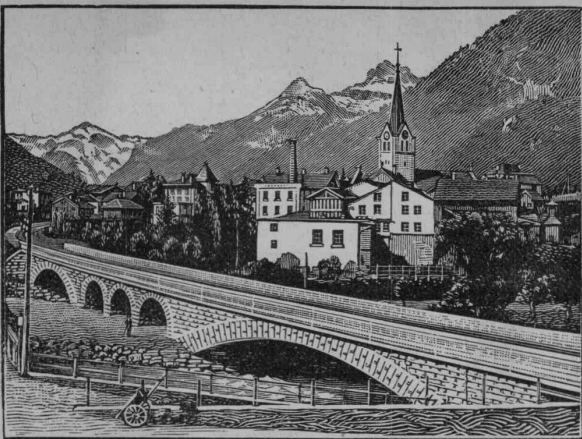
Eisenbahnbrücke ü. d. beiden Lintharme i. Schwanden
