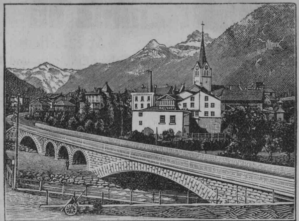
Eisenbahnbrücke ü. d. beiden Lintharme i. Schwanden
