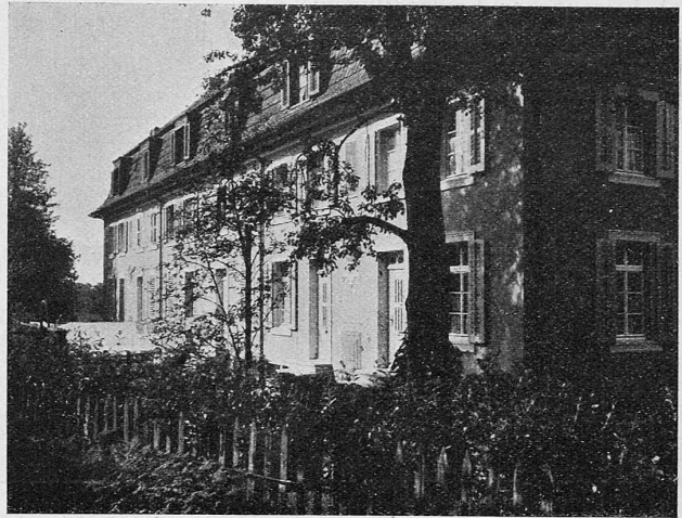
Abb. 5. Ostfront (Strassenseite) des östlichen Baublocks.
