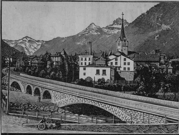
Eisenbahnbrücke ü. d. beiden Lintharme i. Schwanden
