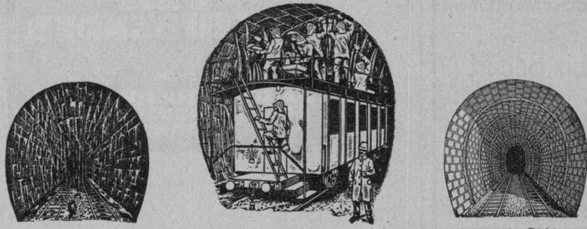
1. Vor der Dichtung nach Öffnen der Fugen      2. Während der Dichtung      3. Nach der Dichtung
