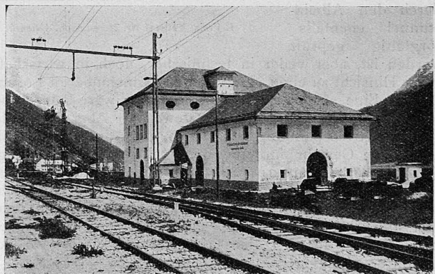
Abb. 17. Umformerstation Bevers der Rhätischen Werke.
