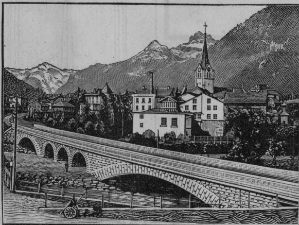
Eisenbahnbrücke ü. d. beiden Lintharme i. Schwanden
