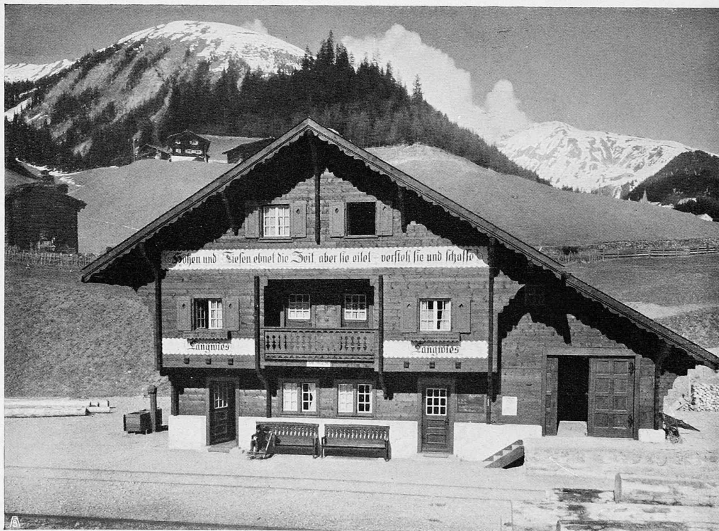
STATIONSGEBÄUDE LANGWIES DER CHUR-AROSA-BAHN
