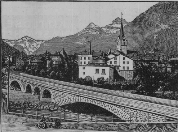
Eisenbahnbrücke ü. d. beiden Lintharme i. Schwanden
