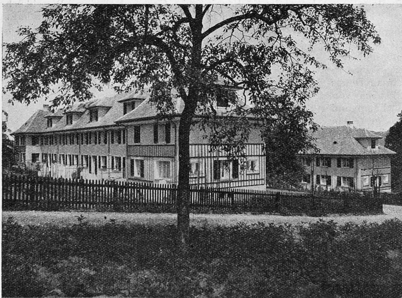
Abb. 8. Süd-Ansicht der Wohnkolonie auf „Rutenen“, Wädenswil.
